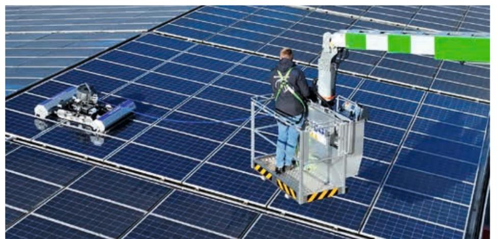
Perfekte Kombination für saubere Solaranlagen: der K950 mit integrierter Wasserführung und Reinigungsroboter
