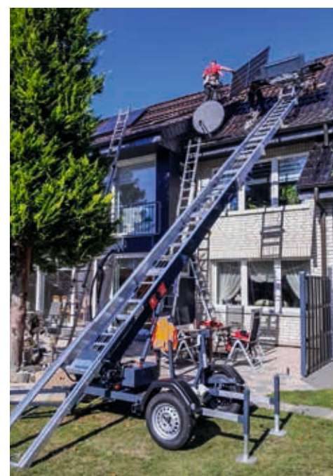
Ungewöhnlich, aber effizient: Der Toplight bringt Solarpaneele aufs Dach.
