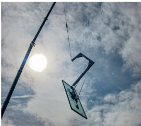
Die Verstellmöglichkeiten des C-Hakens sorgen für eine optimale Positionierung der Glaselemente.
