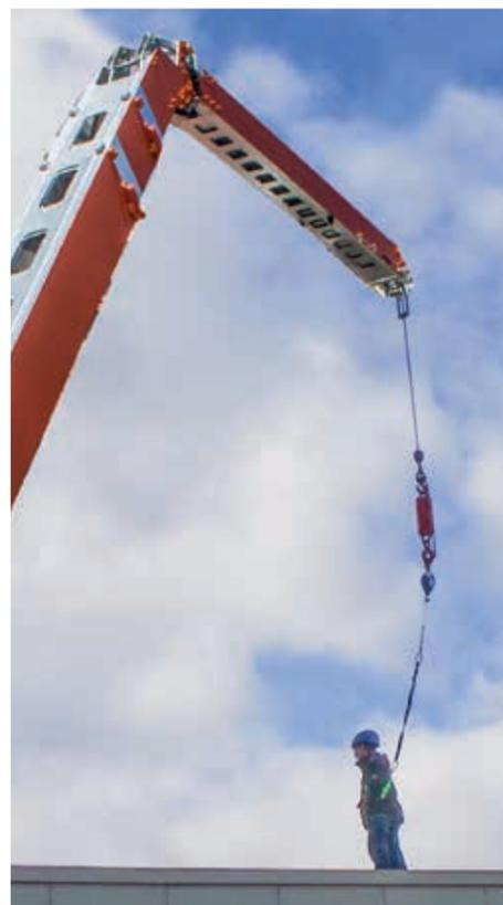
Die Personensicherung ermöglicht das gefahrlose Arbeiten an exponierten Stellen.
