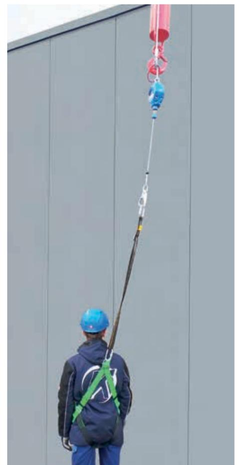
Das Höhensicherungsgerät wird mit dem Gurtgeschirr verbunden.
